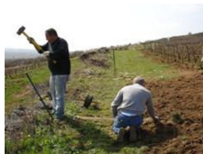
【写真 ワイヤーの杭打ち】
