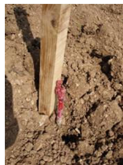
【写真 出来上がり】
